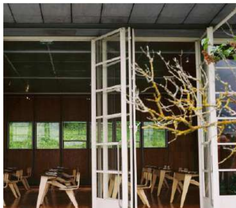
Les hublots en métal et en verre, les assises fixées au pupitre et les panneaux de bois encadrés d'aluminium sont autant de détails signature du style Jean Prouvé. MARION BERRIN POUR M.L. MAGAZINE DU MONDE. ADAGP, PARIS, 2024
